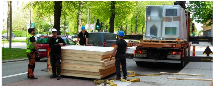
Byggelement och FTX-aggregat klara för upplyftning.
