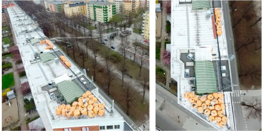
Bilder med 148 F närmast är tagna 25 april och visar omfattande byggarbeten
