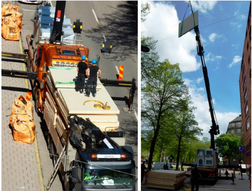
Byggmaterialet lyfts upp på taket längs hela Valhallavägshuset. Storleken på byggelementen uppskattas till ca 2,5 x 2,5 meter. De nya fläkthusen kan uppenbart bli väsentligt större än de som uppgavs i den avslagna bygglovsansökan.
